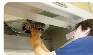
レンジフード清掃
